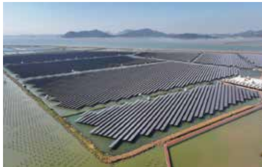
► 广东某能源集团储能项目
